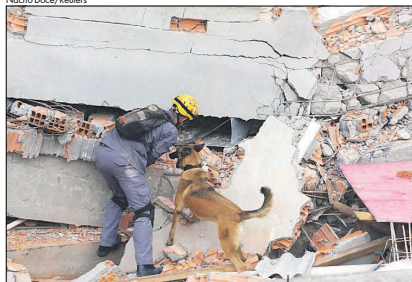
Cães farejadores auxiliaram na busca por corpos em meio aos escombros
